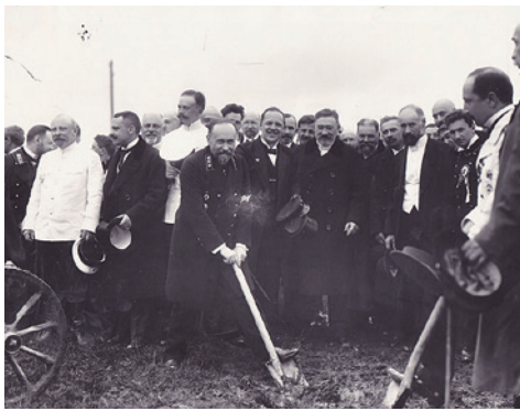
Закладка Ораниенбаумской электрической железной дороги 16 июня 1913 г.
